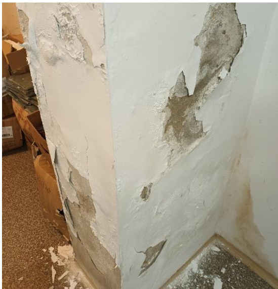
Fot. 1 – Widoczne zagilgocenia ścian piwnicy
