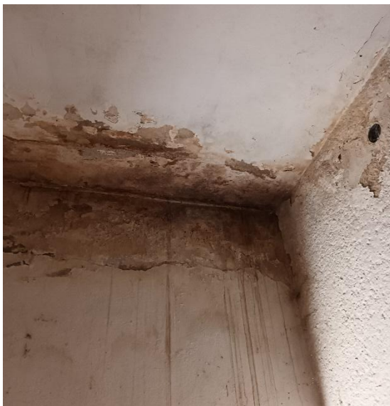
Fot. 2 – Widoczne zagilgocenia stropu nad piwnicą
